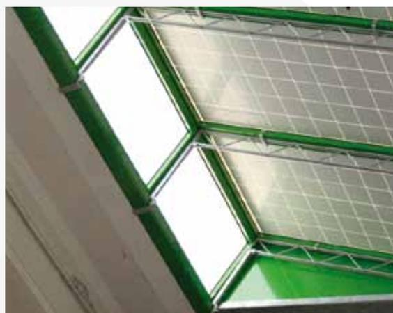
**Coversun** non vincola la dimensione dei moduli fotovoltaici di copertura. Le misure e l'inclinazione vengono compensate dal vano luce finestra che è dunque, determinato dalle dimensioni dei moduli e dall'inclinazione dettata dall'interasse che vincola l'inclinazione dei moduli, per non provocare ombreggiamento tra due campate adiacenti.
